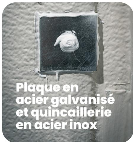
Toutes les barres de sécurité sont supportées à l'arrière de l'appareil avec une plaque en acier galvanisé qui est ensuite enduit de silicone pour éviter la pénétration de la vapeur ou de l'eau.
